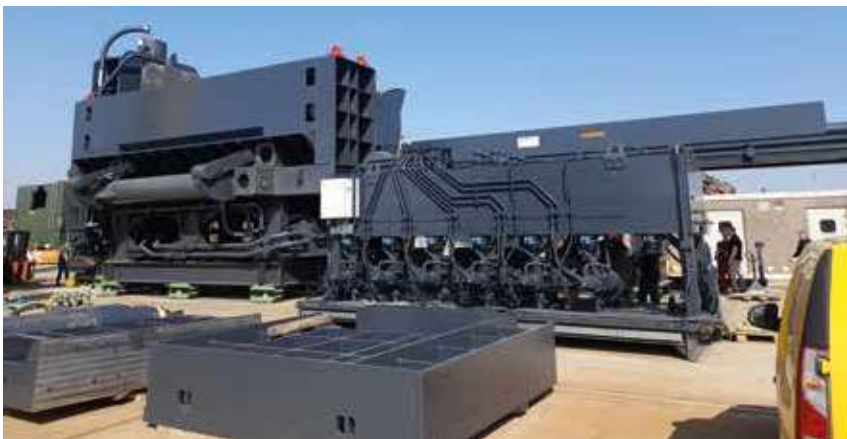
La nouvelle KOLOSS 2000T en cours de montage chez un client.
