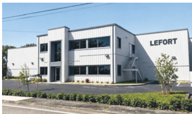
Les installations de LEFORT® America à Sunrise.
